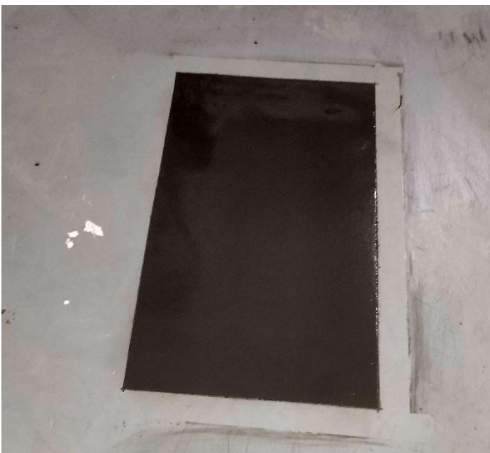
Colocación de piso de poliuretano en zona de ingreso
