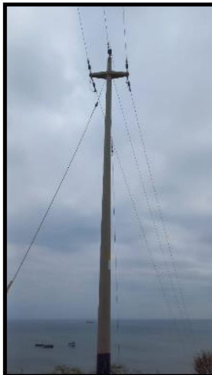
Figura 5. Poste pasante antes del mantenimiento.
