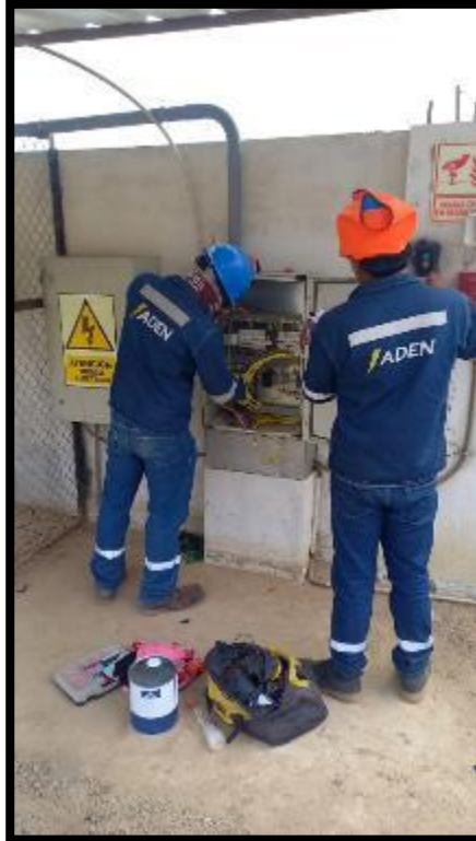
Figura 12. Mantenimiento de tablero de grifo.
