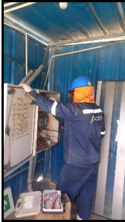
Figura 16. Mantenimiento de tablero de inspección de muelle.
