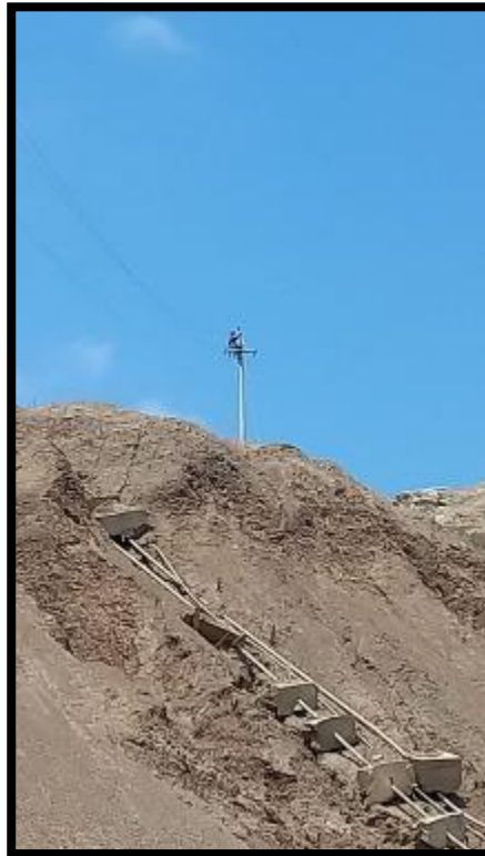
Figura 6. Mantenimiento del poste pasante.
