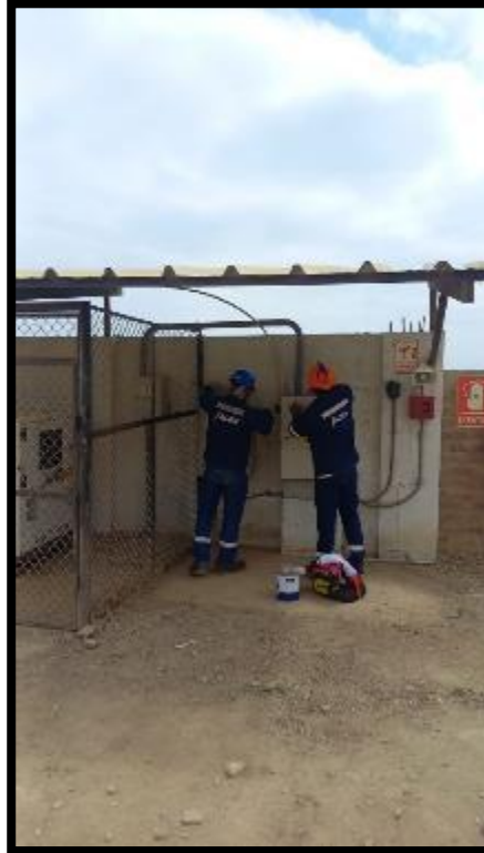
Figura 10. Mantenimiento a los tableros de grifo.
