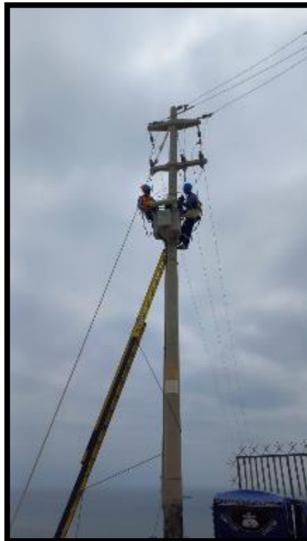
Figura 3. Mantenimiento del trafomix.
