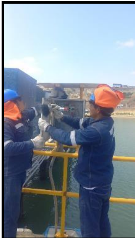
Figura 13. Mantenimiento de tablero entrada de muelle.
