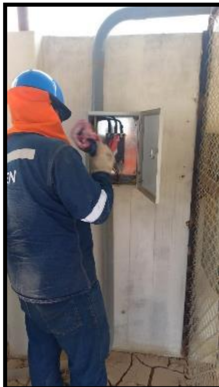
Figura 11. Mantenimiento a tablero general de grupo electrógeno.
