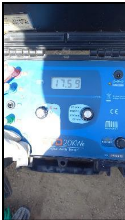
Figura 21. Medición de resistencia del pozo a tierra de subestación media tensión.
