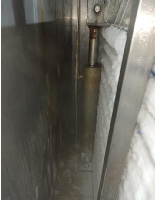
Mantenimiento de piston hidraulico
