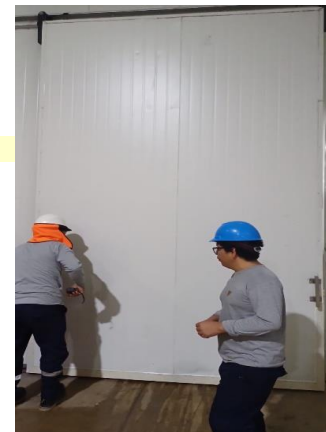
Fotografía de la puerta a desmontar y posteriormente a tapear con pol 100
