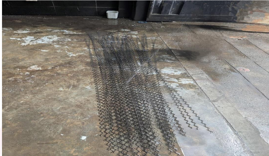
LIMPIEZA DE LOS SERPENTINES DE LOS TUBOS
