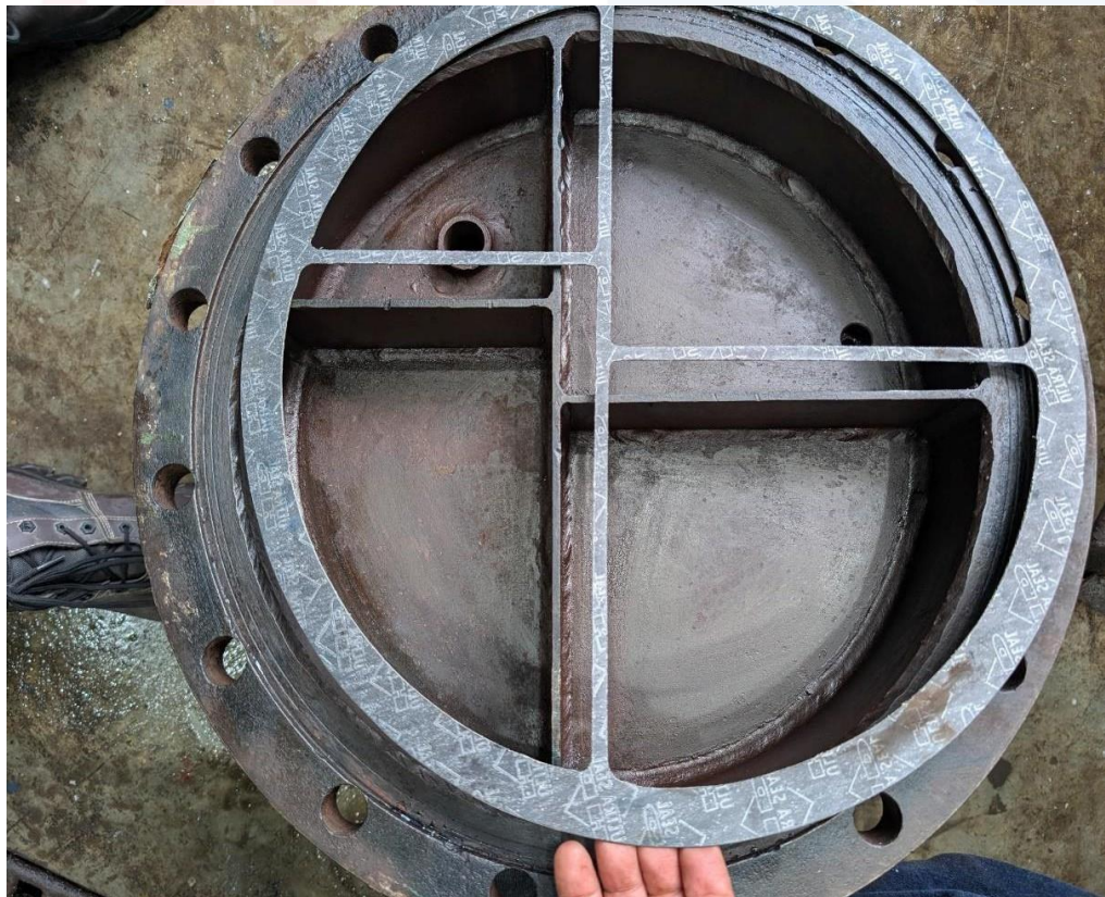
NUEVA EMPAQUETADURA CON SUS DIVISIONES
