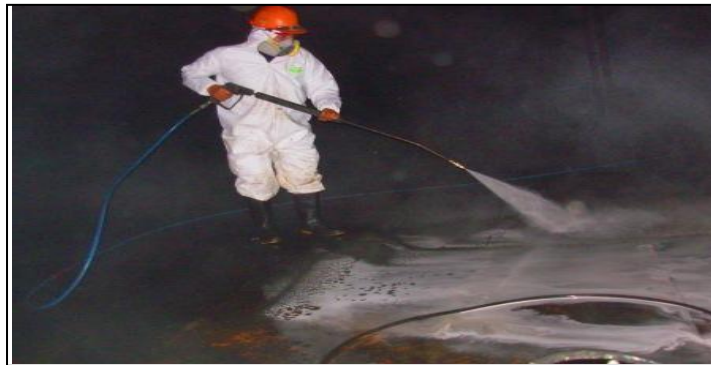
Hidro lavadora de alta presión remoción de todos los lodos
