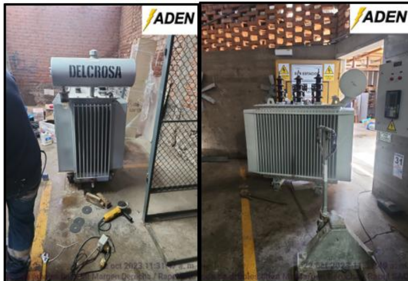
Imagen.02. Montaje de nuevo transformador.
