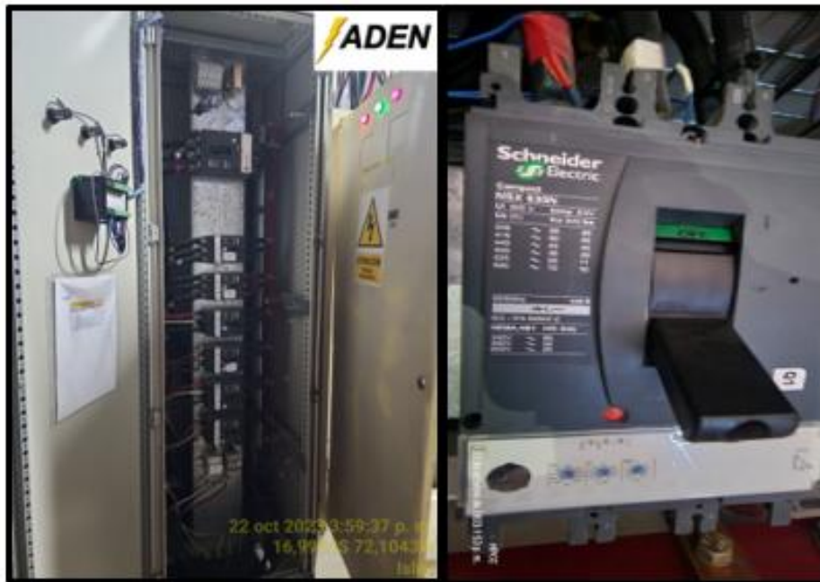
Imagen.06. Conexión de los conductores eléctricos en el tablero.
