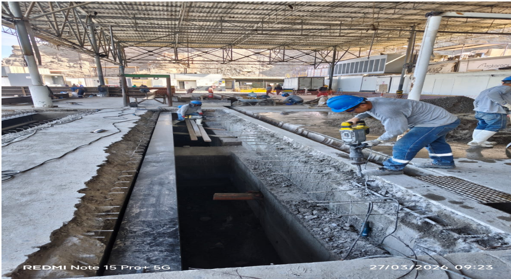
DEMOLICION LOSA TRAMO 04
