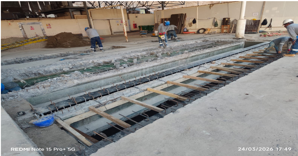
DEMOLICION LOSA TRAMO 04
