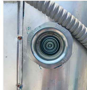
Fig. 10 - Visor limpio y reinstalado en columna.
