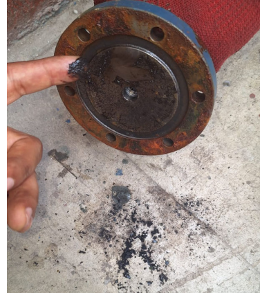
Fig. 4 - Suciedad en tapa de filtro.
