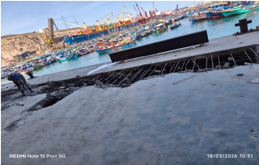
PICADO LOSA TRAMO 05
