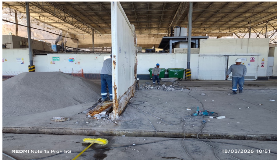
RETIRO PANELES DETERIORADOS
