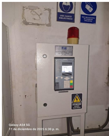
Figura 3.- Limpieza de tablero ERACMF
