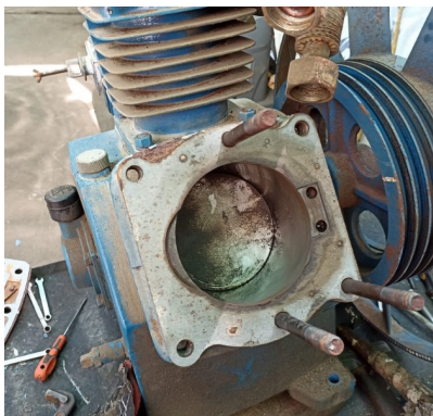
Cilindro destapado para inspección.
