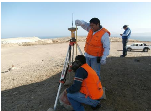
IMAGEN 18 INSTALACIÓN DE UN PUNTO GEODÉSICO
