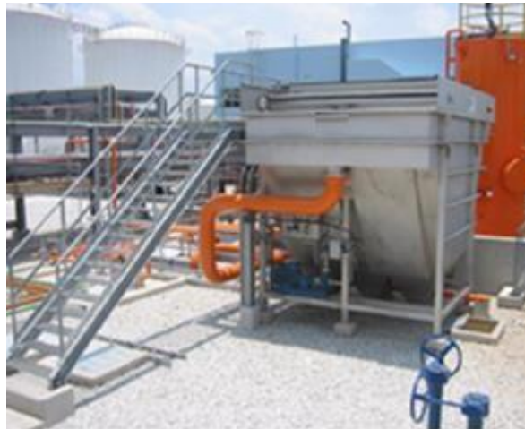
Figura 5: Unidad de Flotación DAF (imagen referencial)
