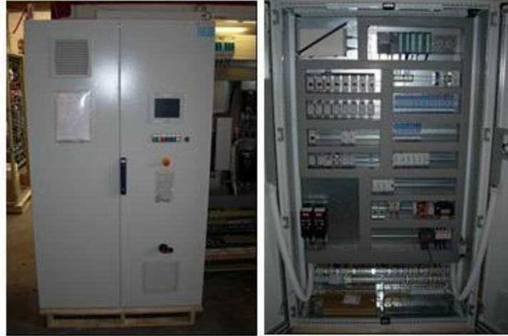
Figura N°7: Unidad típica Panel de Control (Imagen Referencial)
