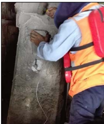
Ensayo PIT – Lateral
