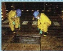
Succión de pozos sépticos. Limpieza y desinfección de trampa de grasa.
