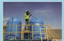
Limpieza y desinfección de tanques de agua.
