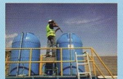
Limpieza y desinfección de tanques de agua.
